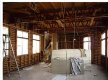
1階会堂解体中状況
