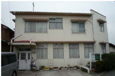
解体前会堂全景
