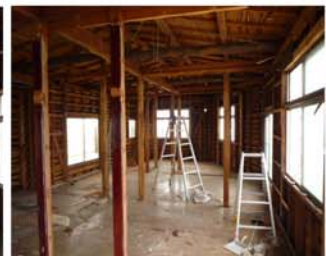
2階牧師住居解体中状況
