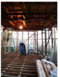
1階会堂解体後状況
