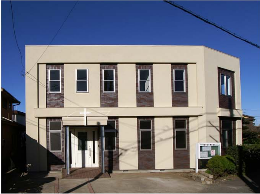
東道路側外観
